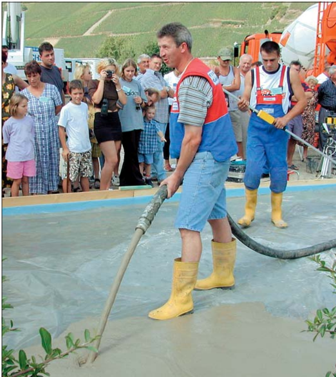
Zwar nicht mehr ganz neu in diesem Handwerk, aber der „schwimmende Estrich“ wird als Arbeiterleichterung auch im Hause Schlag gerne angewendet – wie hier bei einer Demonstration auf dem Betriebsgelände (Foto links). Technisch auf dem neuesten Stand ist das Unternehmen auch beim Maschinenpark (rechts).
